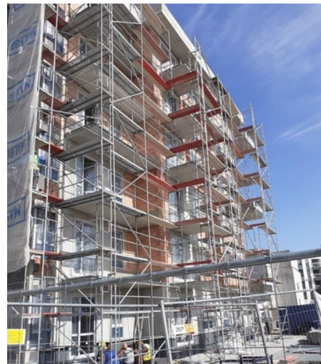
Budowa budynku mieszkalno - usługowego przy ul. Kolorowej 17 w Warszawie
