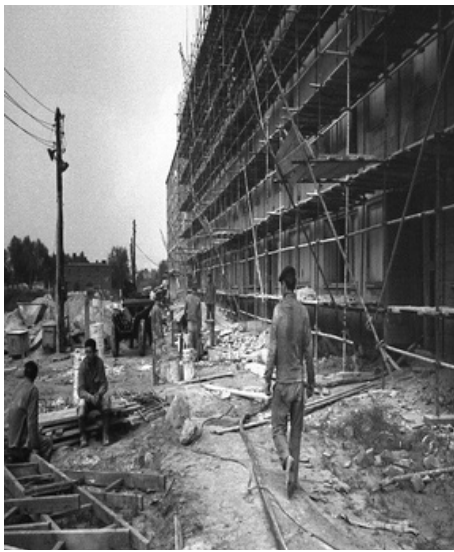
Budowa budynku mieszkalnego przy ul. Wojciechowskiego 40 w Warszawie
