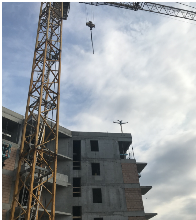
Budowa budynku mieszkalno - usługowego przy ul. Tomcia Palucha 12 w Warszawie
