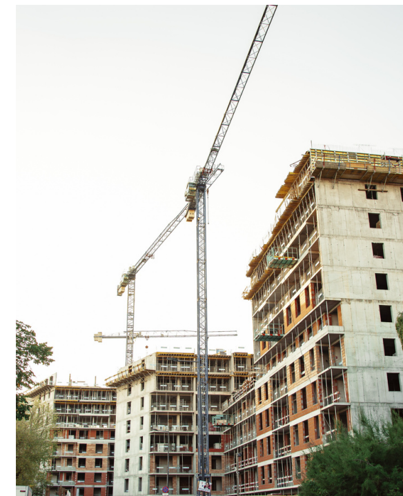
Budowa budynku mieszkalno - usługowego przy ul. Zagłoby 16 w Warszawie
