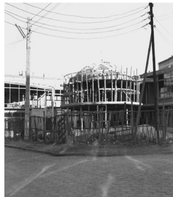
Budowa domu handlowego tzw. „Okraglaka” przy ul. Pużaka 1 w Warszawie
