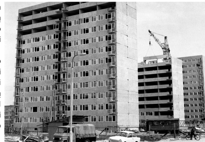
Budowa osiedla „Niedźwiadek”
