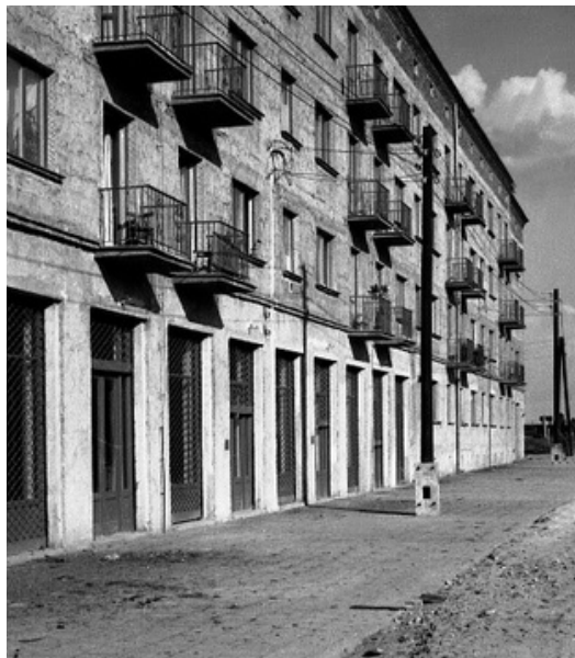
Budynek mieszkalny przy ul. Bohaterów Warszawy 8 w Warszawie
