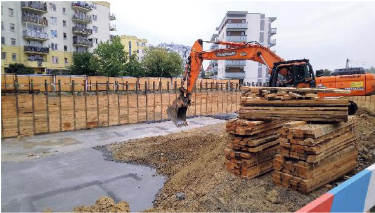
Plac budowy - Tomcia Palucha 12
